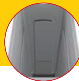
CANALES DE VENTILACIÓN
